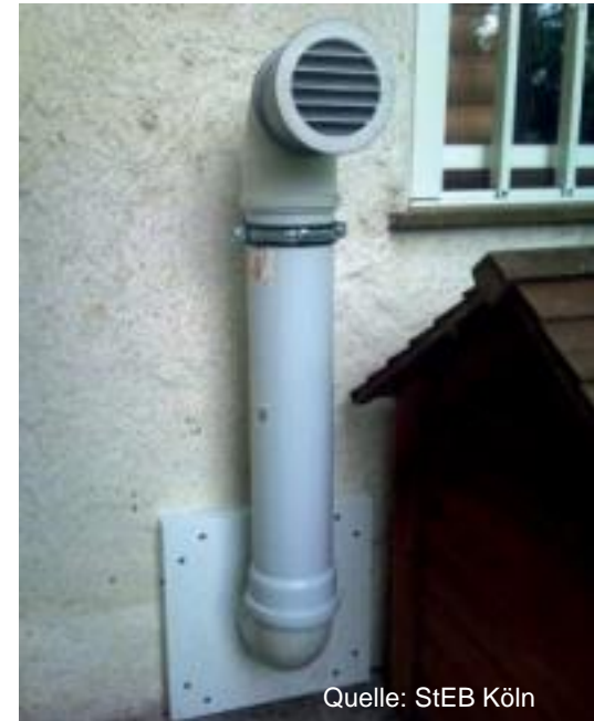
Erhöhte Lüftungen
