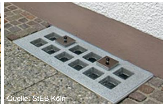
Abgedichteter Lichtschacht
